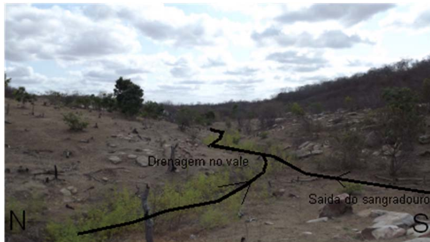
Figura 2.37 - Vale natural a montante do eixo (corte N-S), saída do vertedouro e drenagem natural na direção W-E. Todo o substrato é composto de rocha granítica sã.
